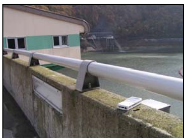
写真-1 ダム天端
